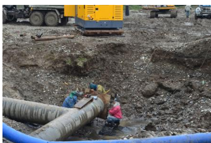
Посещение объекта реконструкции газопровода
